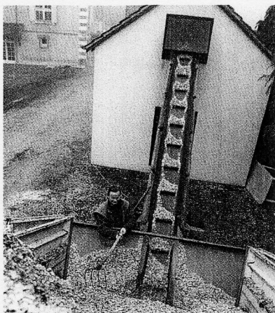
La chaufferie automatique de Villiers-Saint-Benoît
